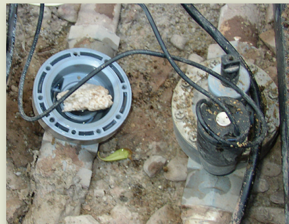
Escombros en las válvulas puede causar fugas previniendo que la válvula se cierre correctamente.
